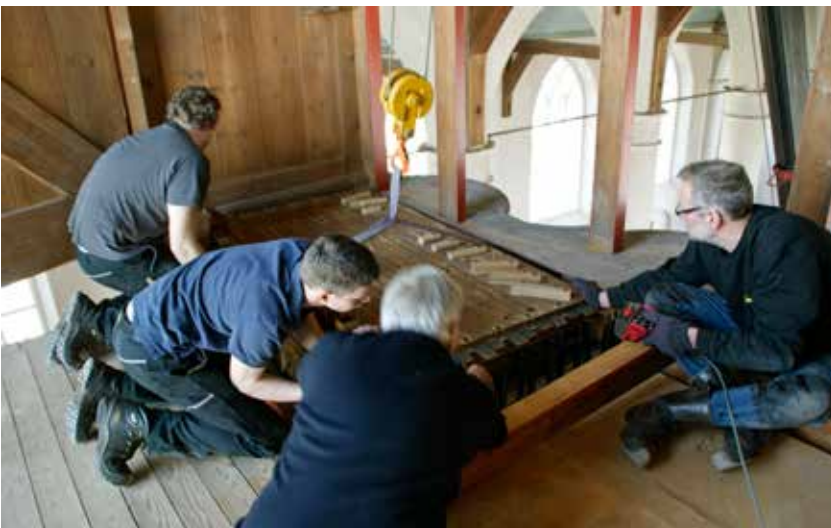
De hoofdwerkklade wordt op zijn plaats gelegd.
